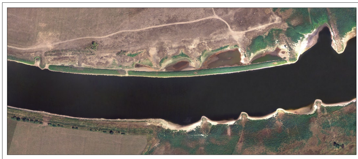
Abb. 7-33: Luftbild eines Parallelwerks, erkennbar als grün bewachsene geschwungene Linie am oberen Ufer; Fließrichtung von rechts nach links. Die Einstromöffnung befindet sich am rechten Ende des Parallelwerks, die zwei Ausströmöffnungen im linken Bereich (August 2003). (Foto: BfG)
