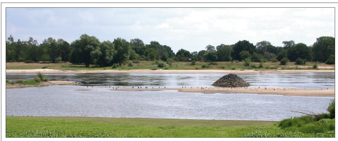
Abb. 7-26: Bühnenfeld bei Elbe-km 418 bis 420 (Juni 2002) mit kleiner Sandbank, auf der sich Wat- und Wasservögel niedergelassen haben. Der auf Vorrat abgesetzte Haufen mit Wasserbausteinen ist zum Aufbau einer neuen Buhne auf der rechten Seite bestimmt, wodurch die Struktur der Lebensräume tendenziell vereinheitlicht wird (Foto: X.-F. GARCIA).
