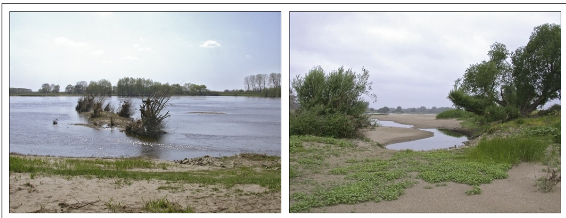
Abb. 7-32: Von Weiden bewachsene und landseitig durchgerissene Buhne (links) (Elbe-km 425, April 2003). Durchgerissene Buhne (rechts) (Elbe-km 424 rechtes Ufer, Juni 2003), deren Reste links und rechts von Weiden bewachsen sind. Ein Kolk stromab des Buhnendurchrisses bildet bei Niedrigwasser einen Tümpel (Fotos: X.-F. GARCIA).
