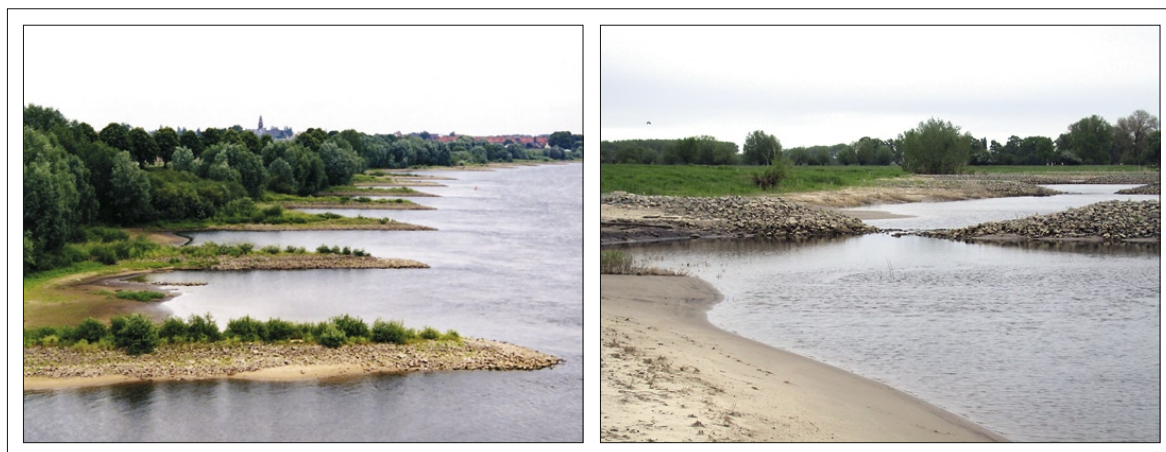
Abb. 7-27: Monotoner Verbau des Elbufers durch Bühnenfelder bei Wittenberge (links) (Foto: R. SCHWARTZ). Versuchsweise erstellte Absenkungsbühnen (Mai 2003) mit dem beabsichtigten ufernahen Nebengerinne (rechts) (Foto: X.-F. GARCIA)
